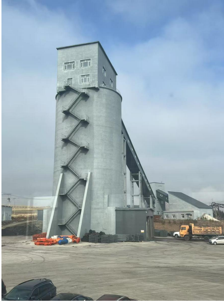
照片 1-4 地面煤仓
