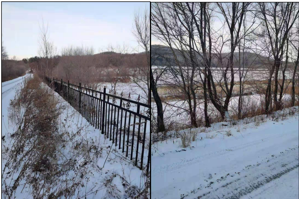
图 1-4 管线经过区域范围现状照片
